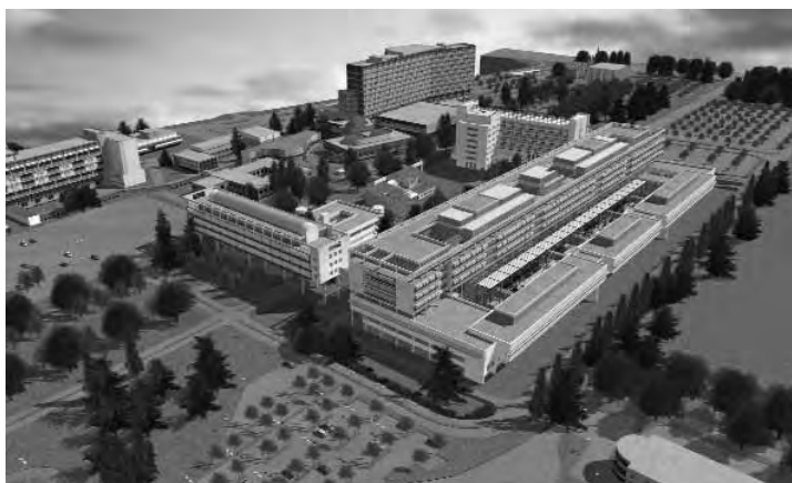
Fig. 28 : L'Hôpital « Pédiatrie et Gynéco-obstétrique » au cœur d'un vaste ensemble hospitalier (ouverture été 2007).
