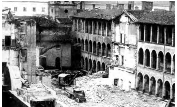
Fig. 13 : L'hôpital en cours de démolition.
