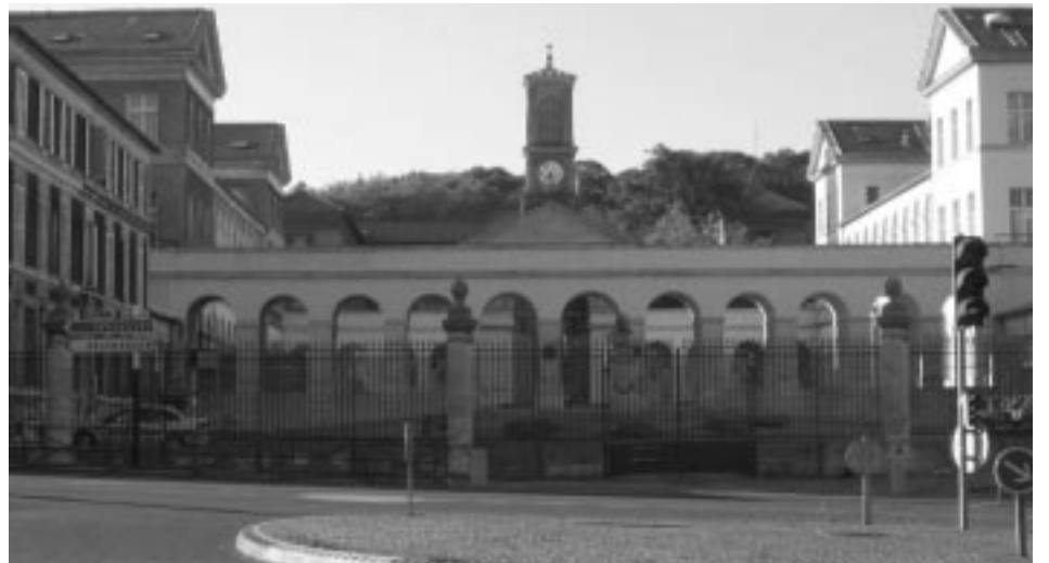
Hôpital Raymond Poincaré à Garches
